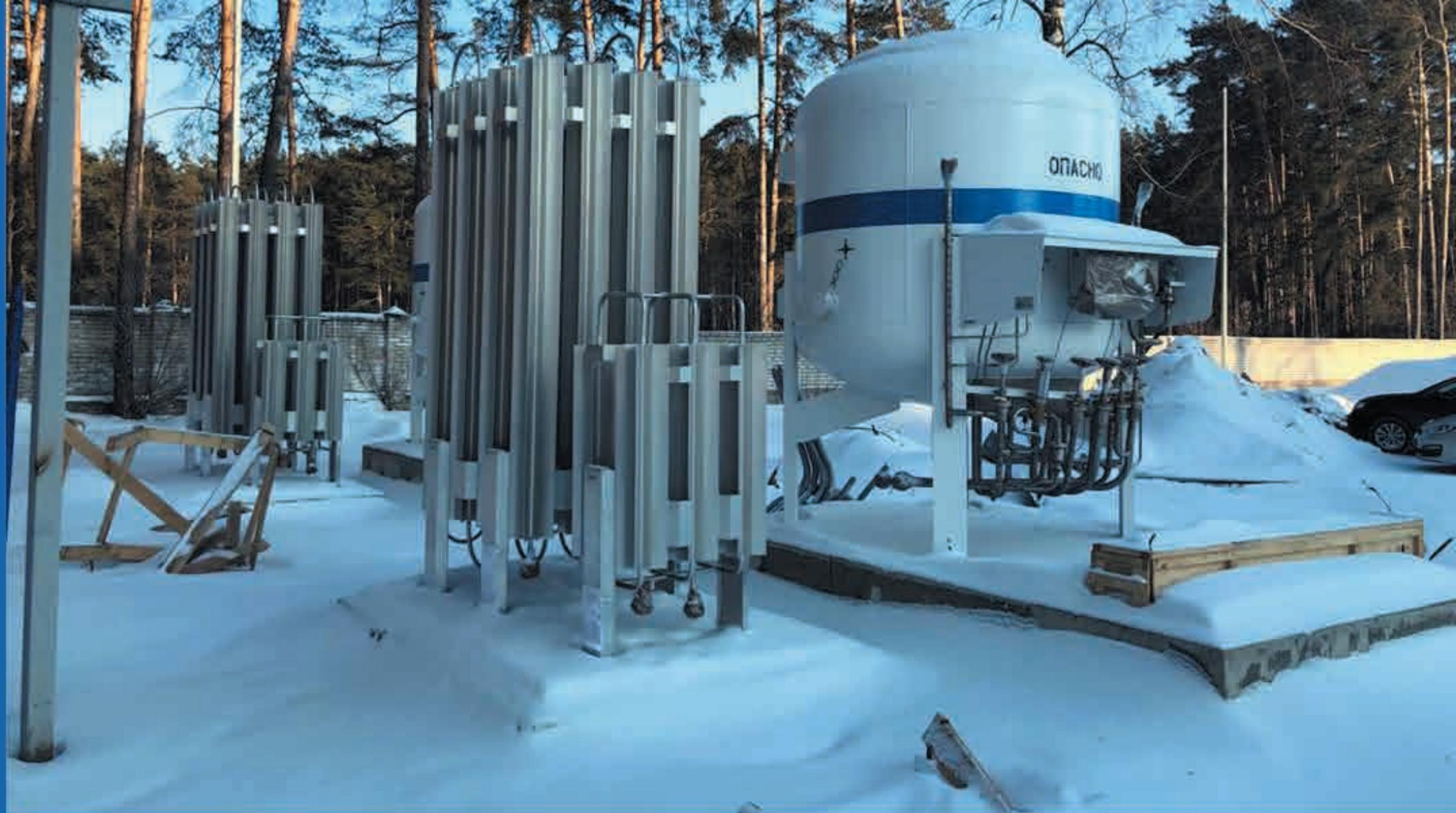
Холодные криогенные газификаторы типа ГХК заводской марки ИНТЕГРА сертифицированы в соответствии с ТР ТС 032/2013 «О безопасности оборудования, работающего под избыточным давлением». Завод-изготовитель гарантирует качество и безопасность поставляемого оборудования в соответствии с действующими стандартами.
